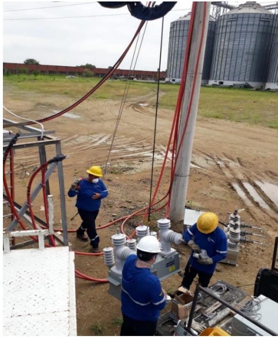
Figura 26: Personal instalando reconectores Fuente: Autores
