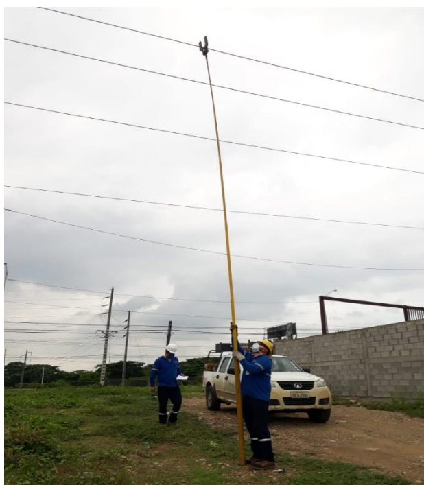
Figura 22: Toma de lecturas de corrientes Fuente: Autores
