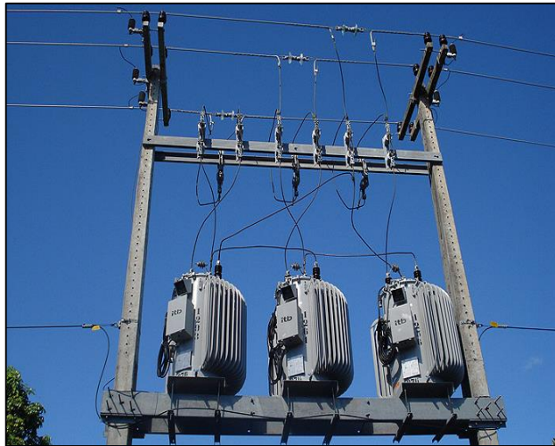
Figura 2: Regulador de voltaje de media tensión Fuente: www.editores-srl.com.ar
