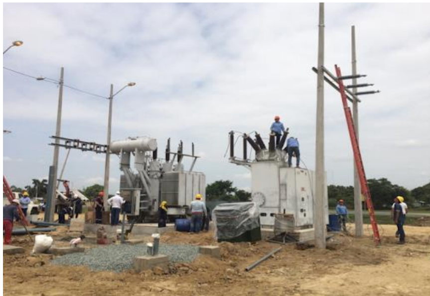
Figura 13: Construcción de la subestación Santa Lucia
