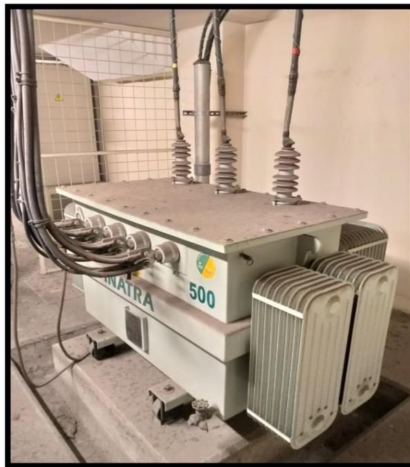
*Figura 61 Transformador Trifásico de 500KVA*
