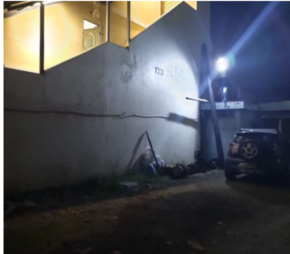
Figura 38 Prueba de Iluminacion
