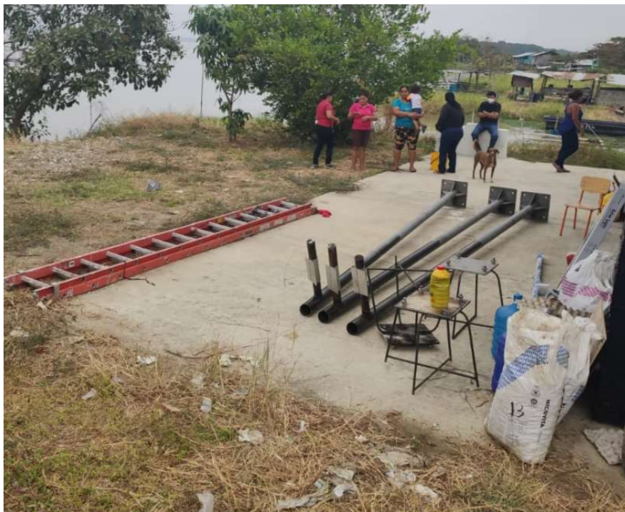
Figura 40 Colocación de plataforma
