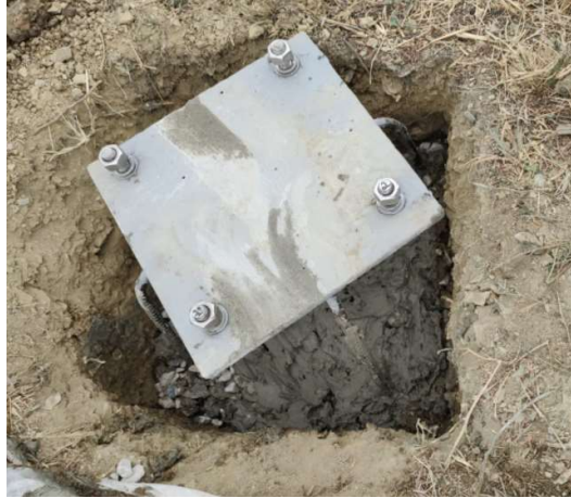
Figura 39 Colocación de la base
