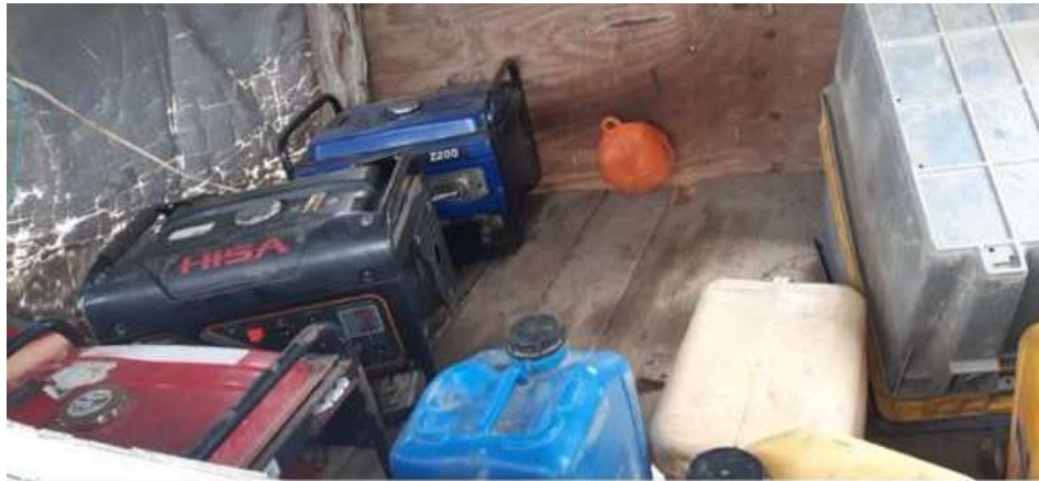
Figura 1 Generadores eléctricos utilizados en el recinto La Masa 2
