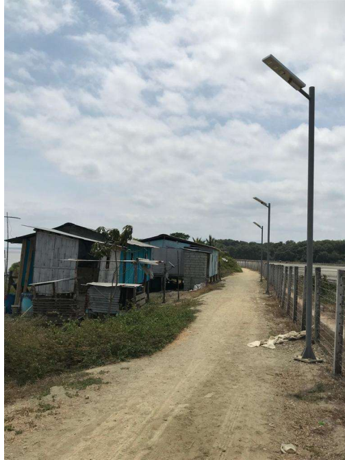
Figura 41 Finalización de obra
