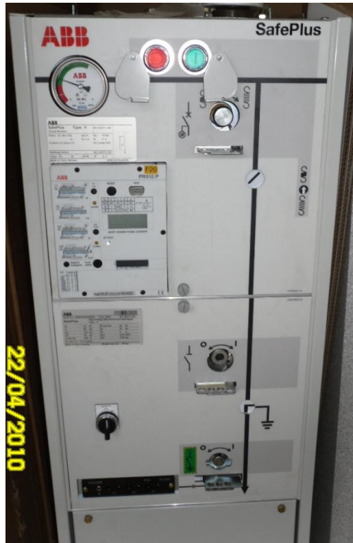
Figura 3.3 Celda Modular Aislada en SF 6 SafePlus 24kV. Fuente: Autores
