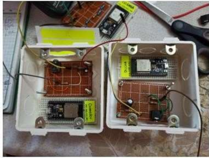
Figura 111 Se observa cómo van colocados los elementos en sus respectivas cajas sobrepuestas para ser instalados en las diferentes partes de la residencia.
