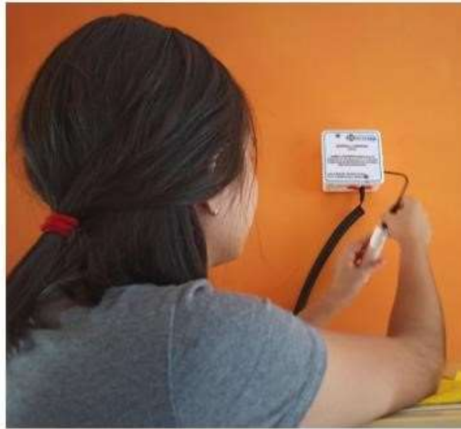
Figura 125 Alimentando el sensor 2
