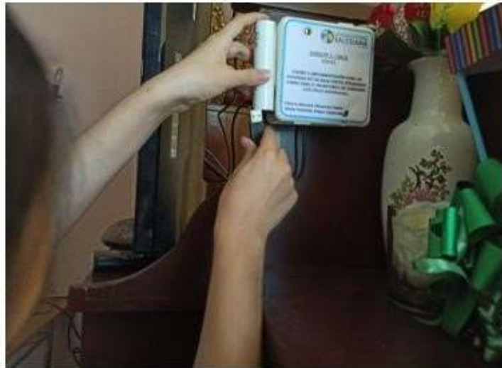
Figura 24 Instalando el sensor1 – sala
