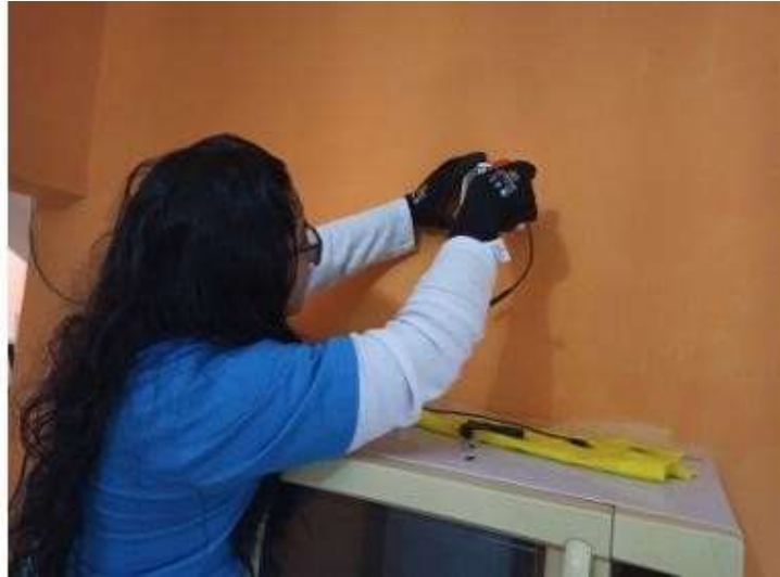
Figura 115 Instalación del sensor 2 – comedor.
