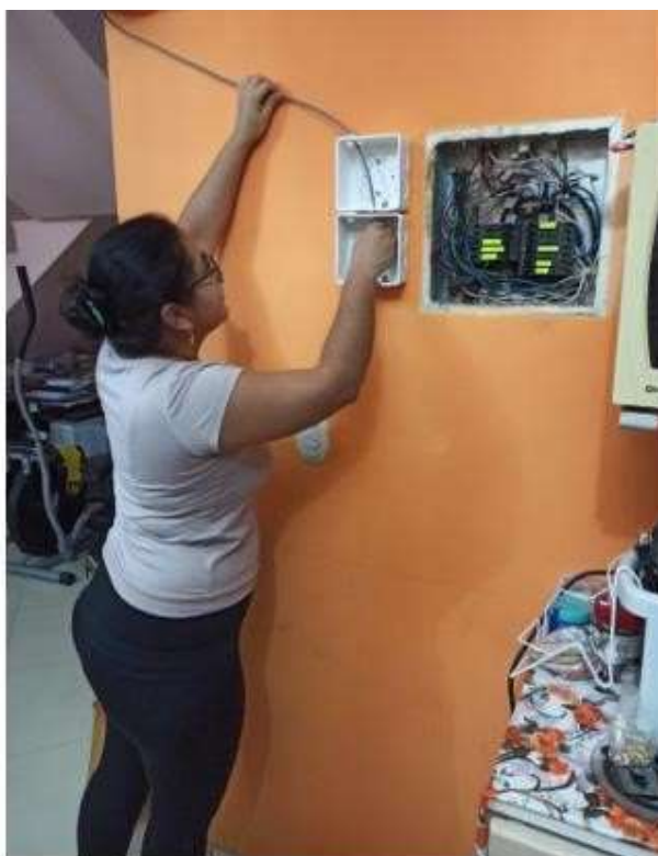
Figura 100 Instalado las cajas sobrepuestas para el servidor principal y colocando un cable de red.
