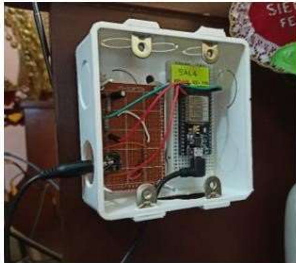
Figura 114 Instalación de sensor 1 – sala, éste solo necesito una cinta doble faz para dejarlo fijo.
