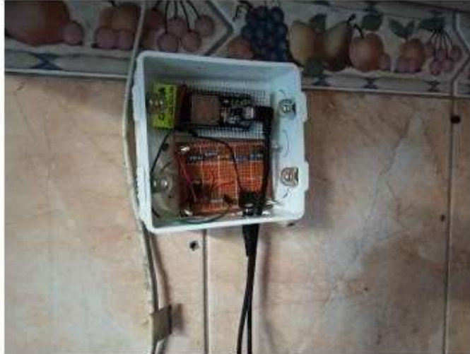
Figura 84 Instalación del sensor3 – cocina.
