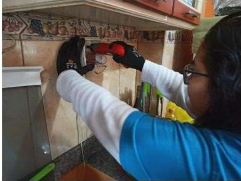
Figura 117 Instalación del sensor 3 – cocina.
