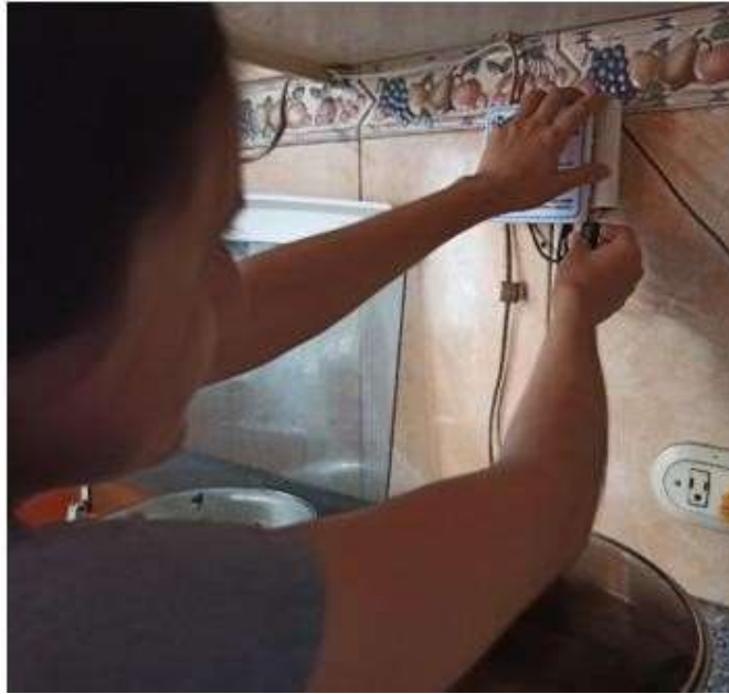
Figura 127 Alimentando el sensor 3
