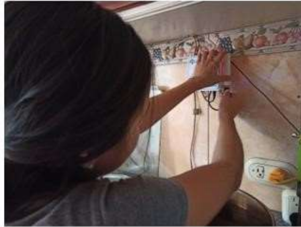
Figura 28 Instalación del sensor 3 – cocina
