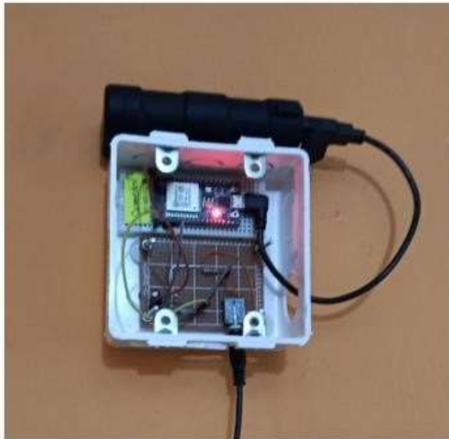
Figura 83 Instalación del sensor2 – comedor.
