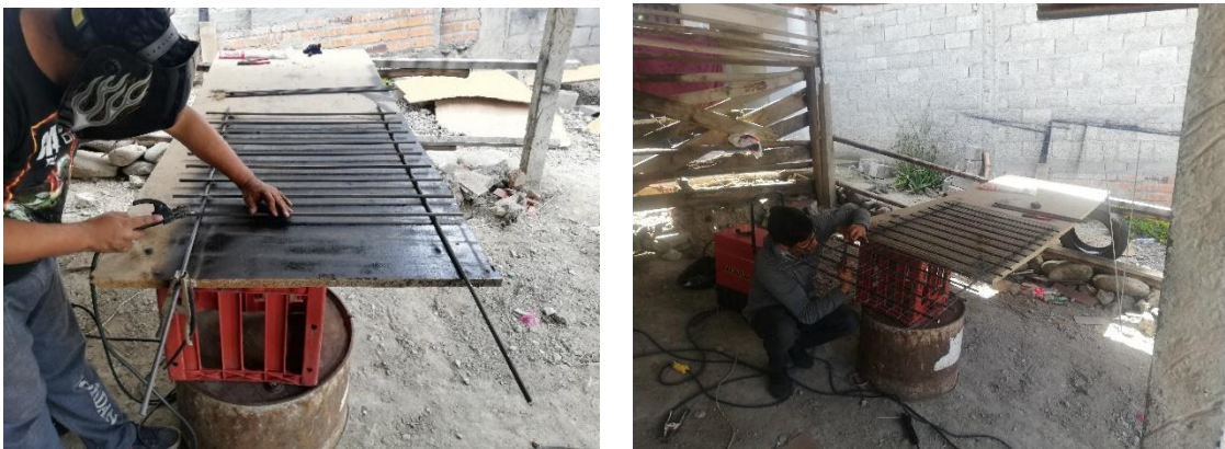
Figura A.1. Elaboración de parrillas de seguridad. Fuente: autores
