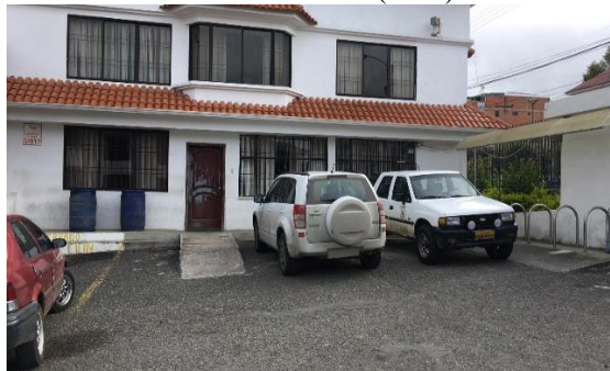
Ilustración 43: Zona de Parqueo de Maquinaria Liviana. Fuente: Autores. (2020).
