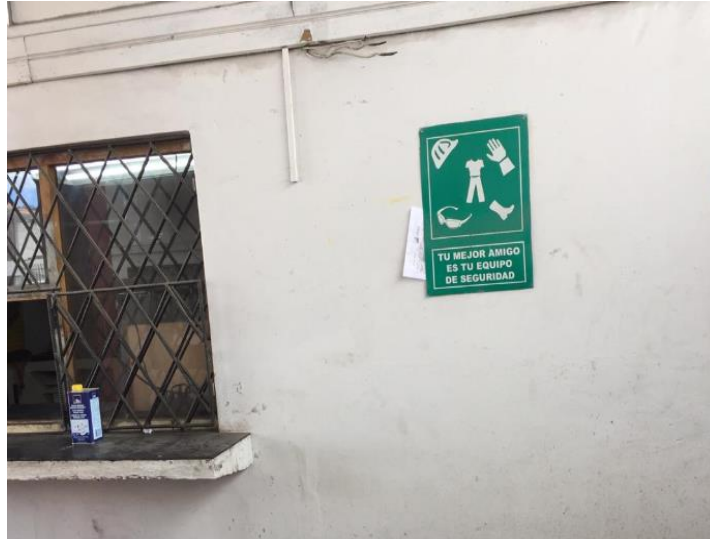
Ilustración 4: Taller del MTOP del Cañar, zona reparación sin señalética. Fuente: Autores. (2020).
