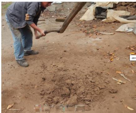
Figura 9. Desterronamiento manual de la arcilla
