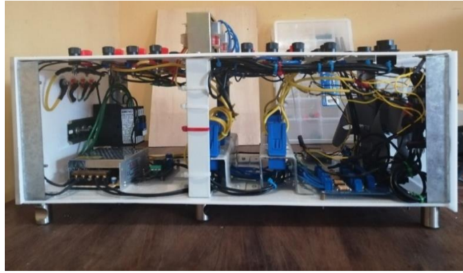
Figura. 78 Parte interna del módulo.
