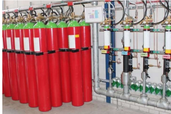
Figura 12 Cilindros CO 2
