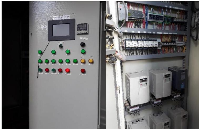
**Figura 16.** Panel de control para el área del secado de madera
