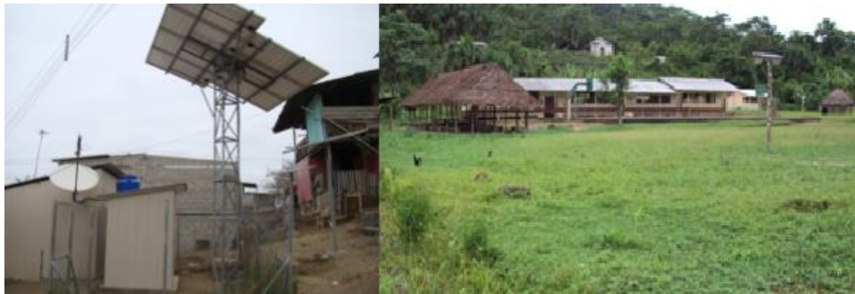
Figura 3. Ejemplos de Electrificación Rural en el Ecuador [60]
