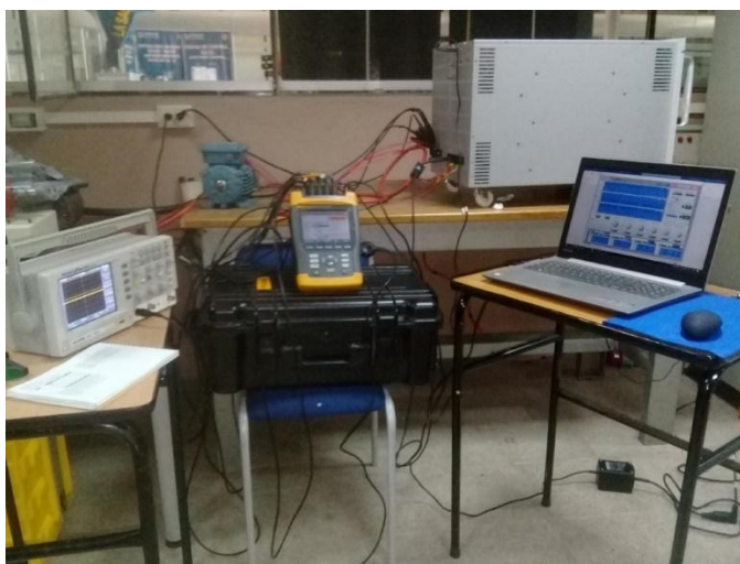
Gráfica 11: Conexión equipos para el análisis de calidad de la energía eléctrica. FUENTE: Autor.
