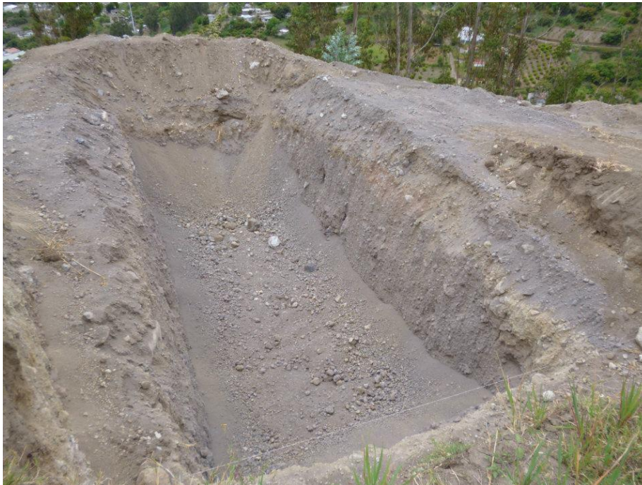
Fuente: Asociación Agropecuaria Quinlata. / Trabajo Comunitario/ excavación reservorio.
