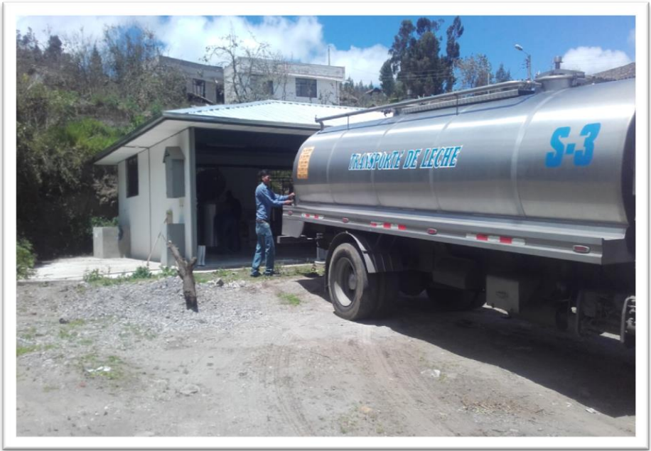
Fuente: Archivo de la UOCAIP- Pasa. Centro de enfriamiento lechero
