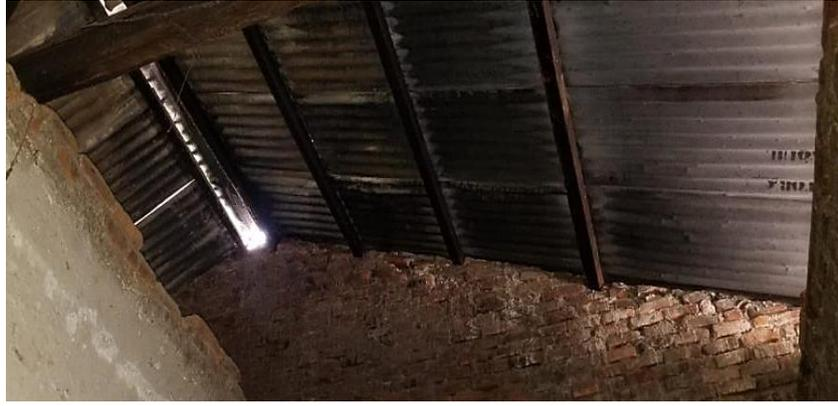
*Figura 7.* Apoyo de correas sobre muros de ladrillo
