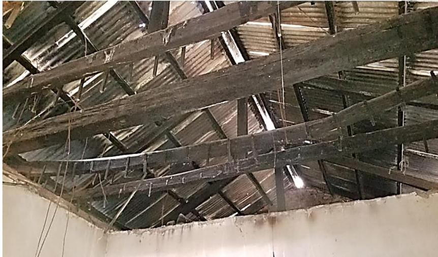
*Figura 9.* Conformación de las cerchas y evidente deterioro de la cubierta
