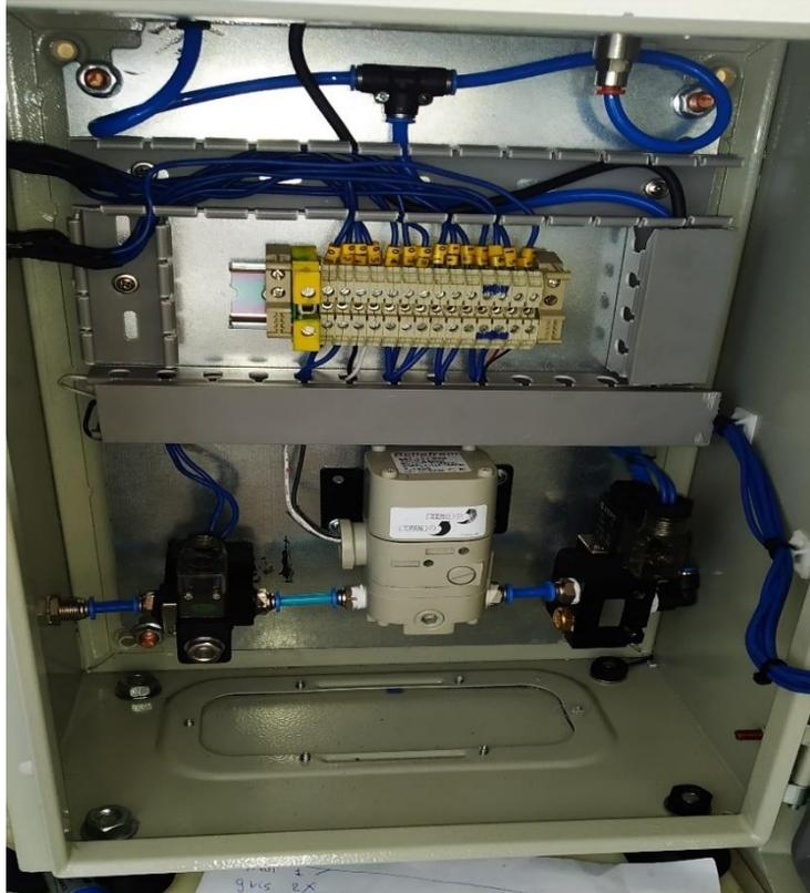
Figura 34. Elementos de tablero de planta de calibración de Presión. (Los Autores).
