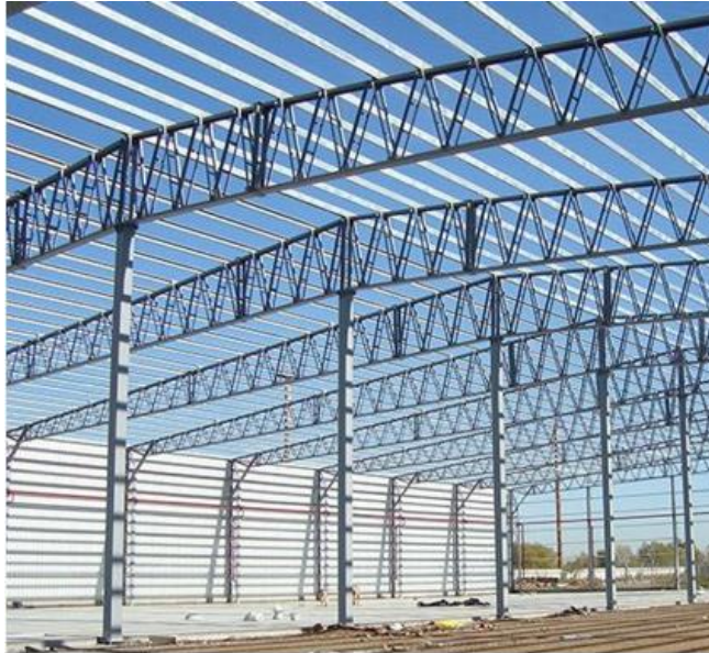
Figura 12. Estructura de acero de tipo armadura [34]
