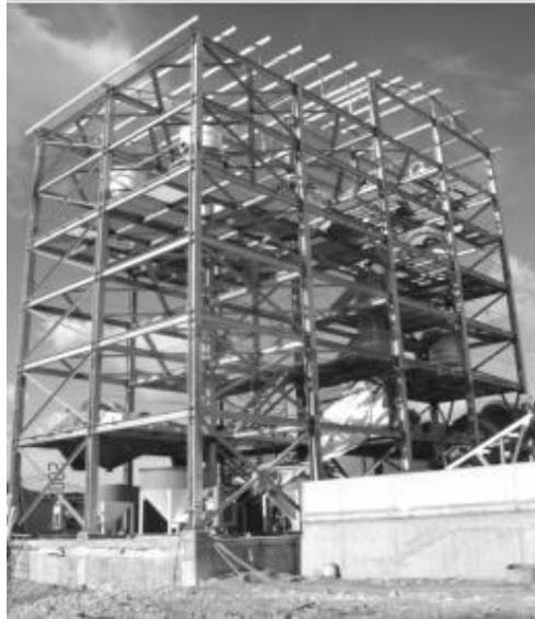
Figura 10. Estructura de acero aporticada [31]
