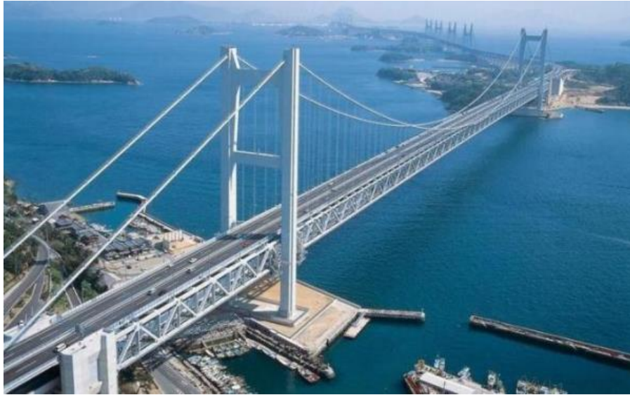
Figura 13. Estructura de acero de tipo colgante [35]
