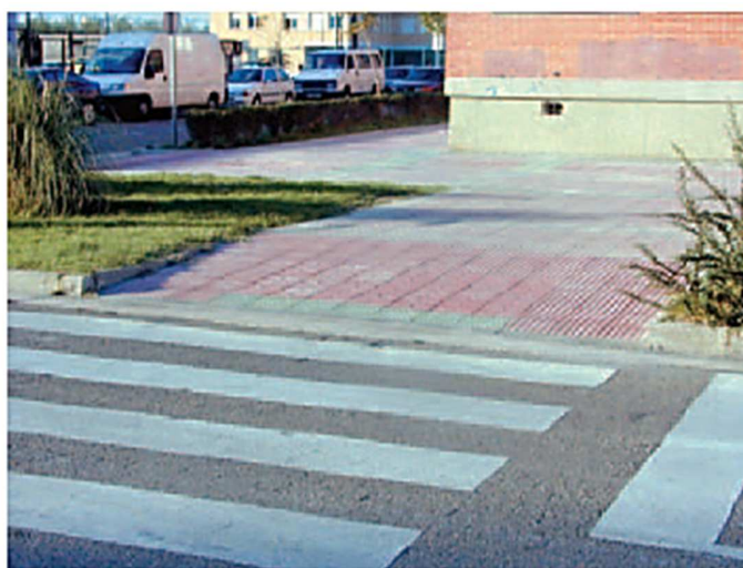
Figura 16: Desnivel en acera.
