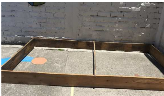
Figura 20. Construcción de cajoneras de madera.
