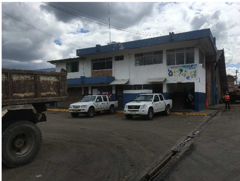
Figura 7. Instalaciones del departamento de Talleres del GPA.
