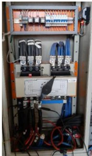
**Figura 4.** Sistema de transferencia automática ATS
