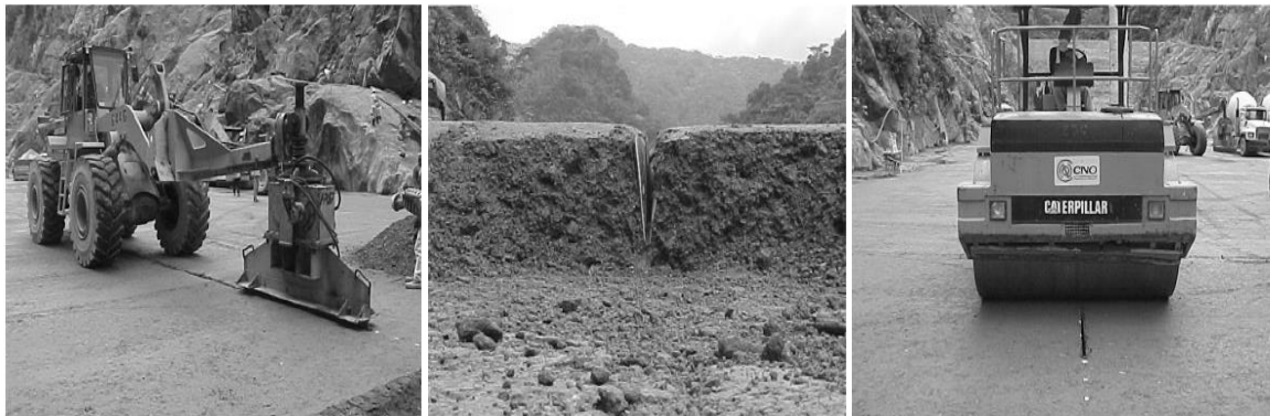
Figura 2-44. Insertado de junta, presa Miel I, Colombia. Fuente: (USACE, researchgate.net, 1992)
