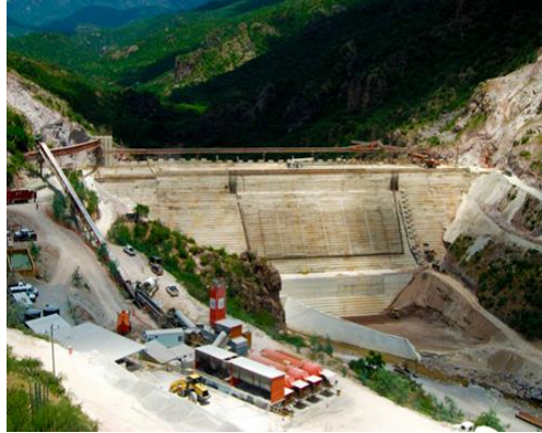
Figura 2-70. Planta móvil de concreto utilizada en la construcción de la presa El Realito, Guanajuato, México.
