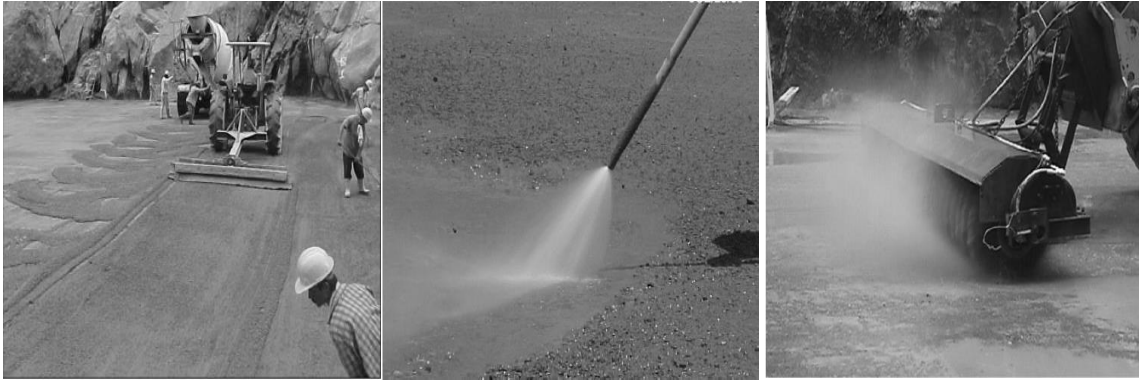
Figura 2-45. Tratamiento de una junta de elevación, presa Miel I, Colombia. Fuente: (USACE, researchgate.net, 1992)
