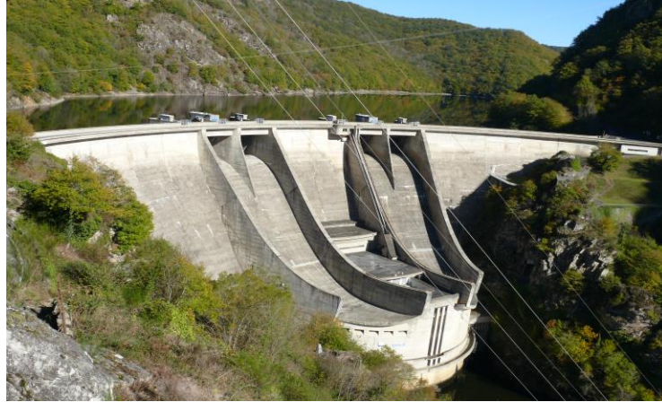
Figura 2-35. Vertedero tipo esquí Presa L'aigle, Francia. Fuente: (Guy, 2010)
