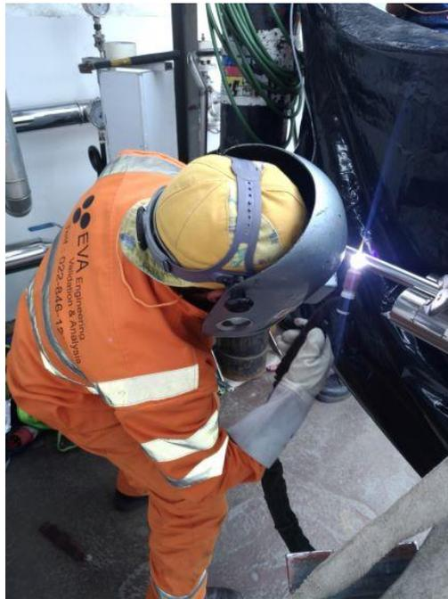
Figura 19. Soldador realizando las pruebas de parámetros óptimos TIG soldadura manual, Gamarra (2020)
