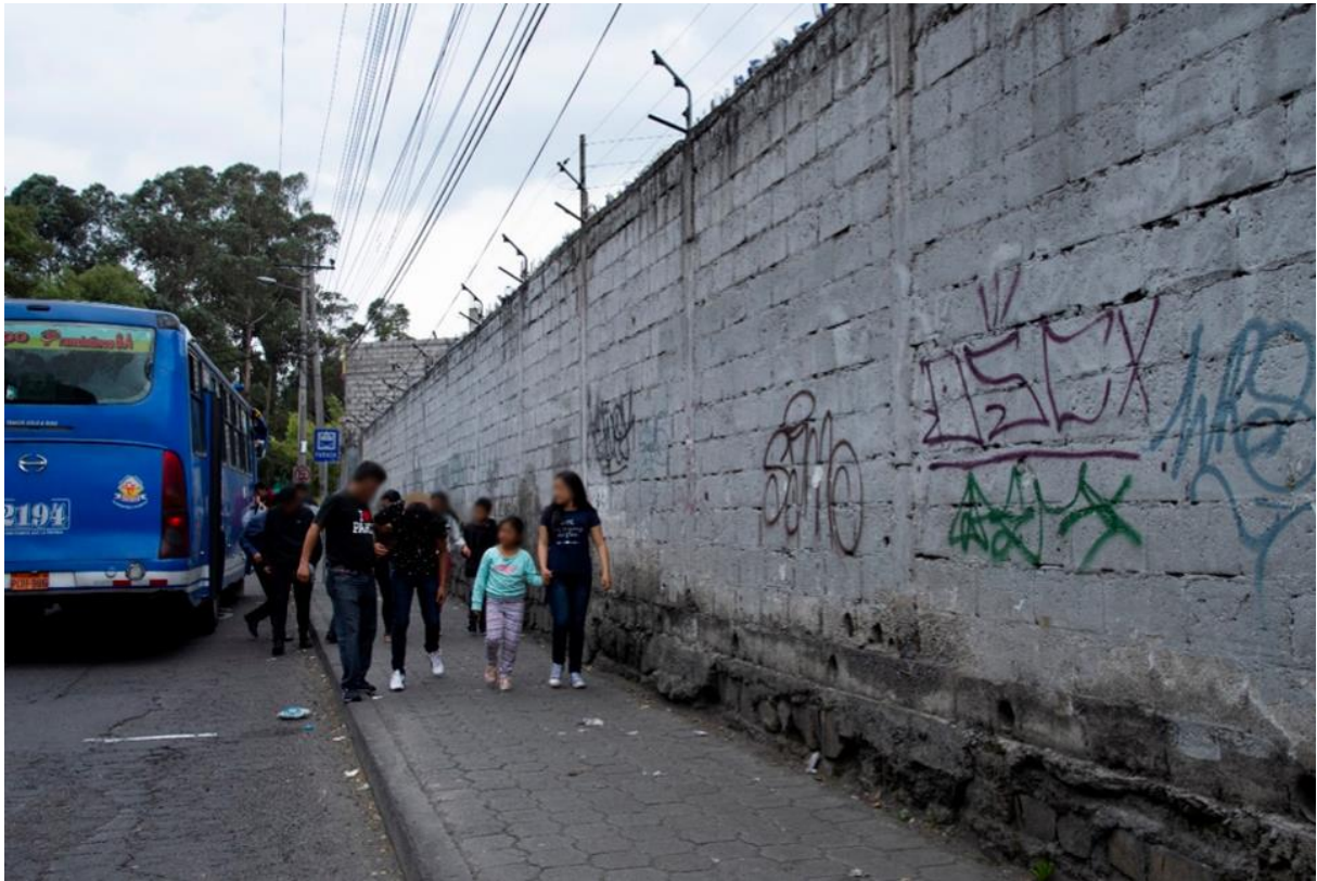
Foto 5: Fotografía tomada en la tarde, se observan grafitis, paredes destruidas y parada de bus.
