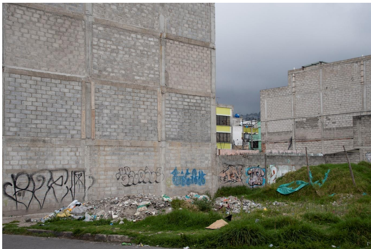
Foto 15: Se observa terreno vacío lleno de basura y grafitis en las paredes.
