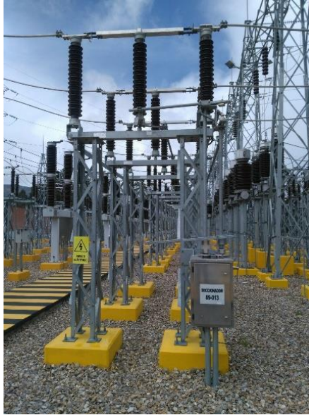
Figura 30. Seccionador 89-013 [52].
