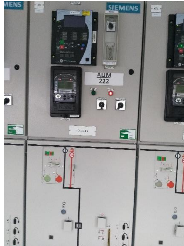
Figura 35. Monitoreo del Alimentador 222 con elementos SIEMENS [52].
