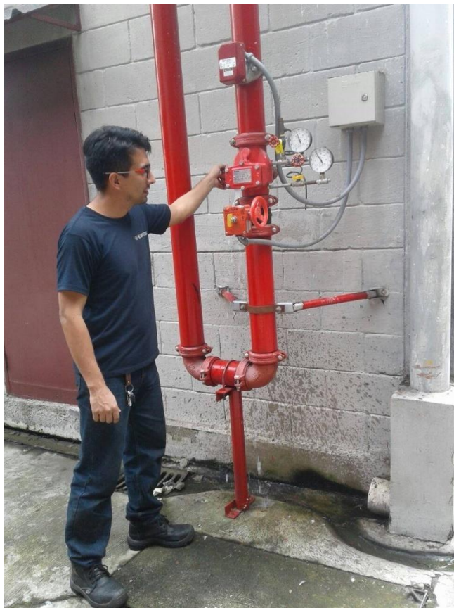
Sistema de válvulas de supervisión o secado
