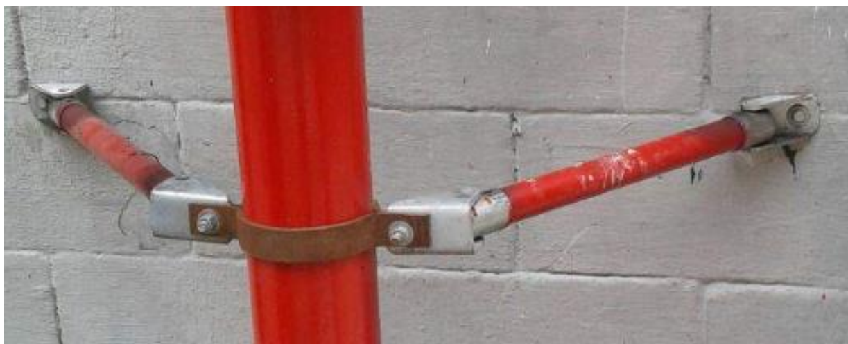
Soportes angulares de sujeción y antisísmico
