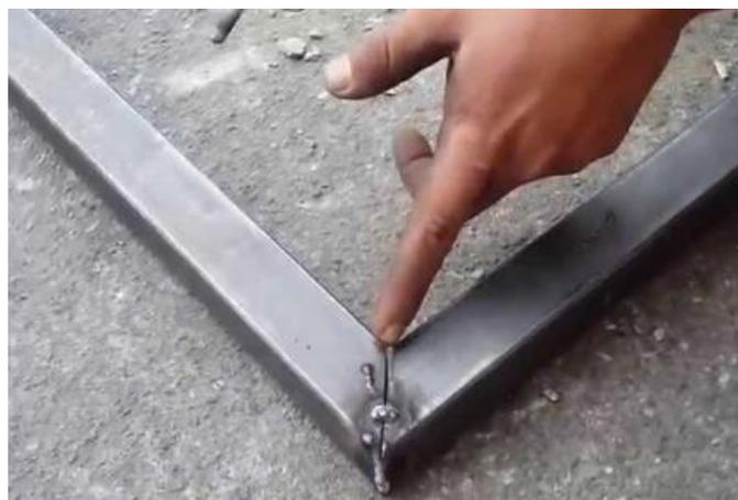
Figura 3-4. Unión de piezas mediante un punto de suelda.
