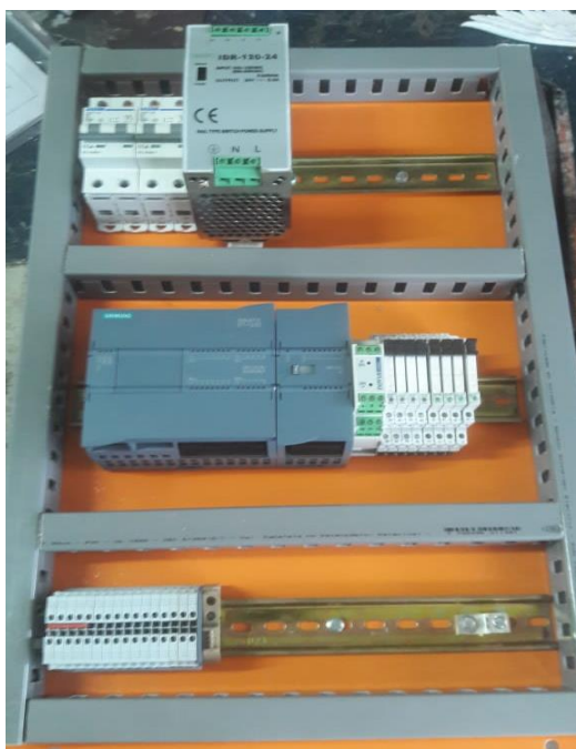
Figura 43. Montaje de componentes en el tablero 1
