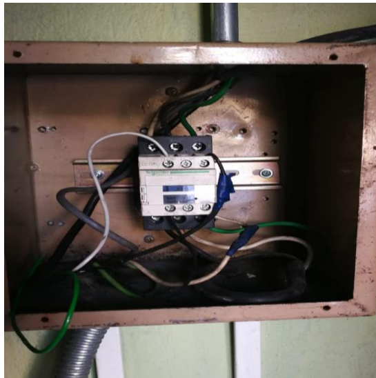
Figura 45. Instalación de guardamotor
