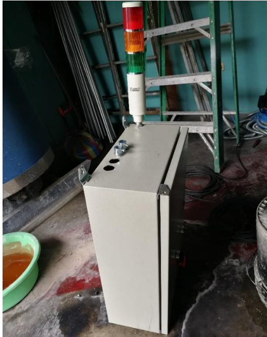
Figura 46. Instalación de componentes
