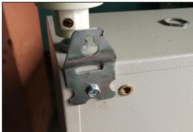
Figura 48. Fijación de tableros
