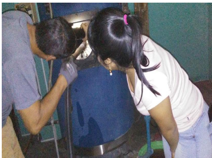
Figura 40. Limpieza de conductos
