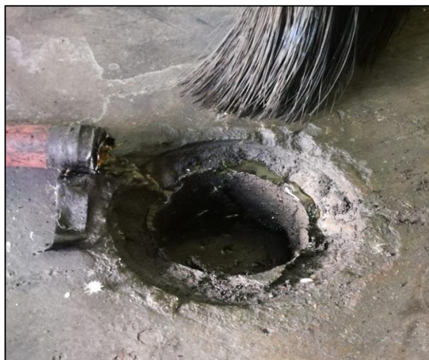
Figura 42. Instalación de tubería hacia desagüe
