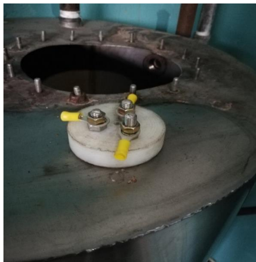
Figura 50. Instalación del detector de nivel
