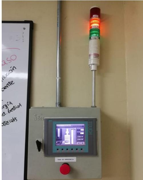
Figura 55. Caldero y bomba encendido tablero 2
