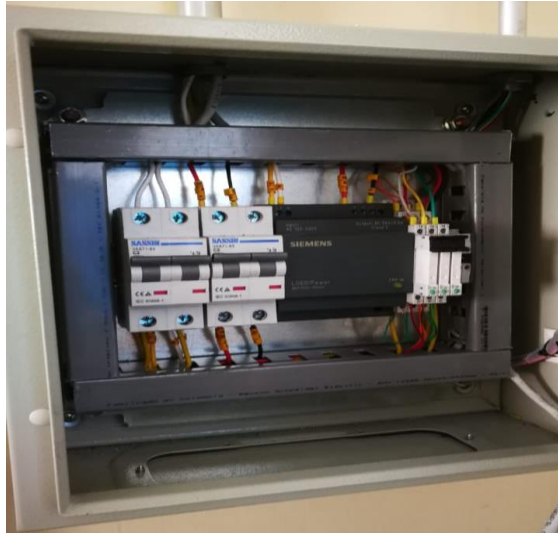
Figura 44. Montaje de componentes en el tablero 2
