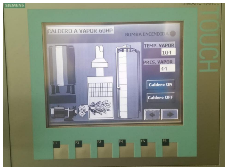
Figura 56. Bomba encendida desde la pantalla HMI.
