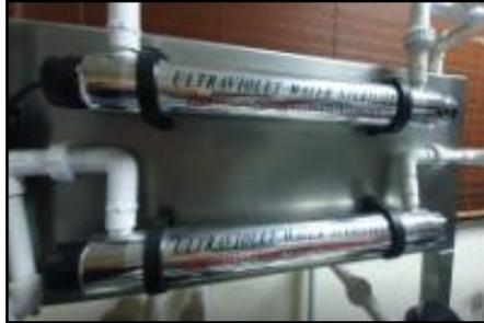
*Figura 2.6 Purificador ultravioleta*
