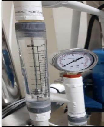
**Imagen 10:** Rotámetro y manómetro de caudal permeado
