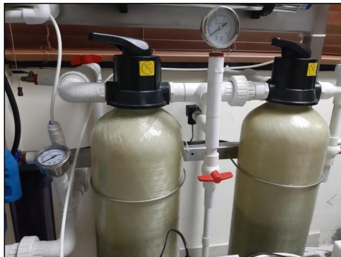
**Imagen 11:** Lechos filtrantes de carbón activado y sedimentos
