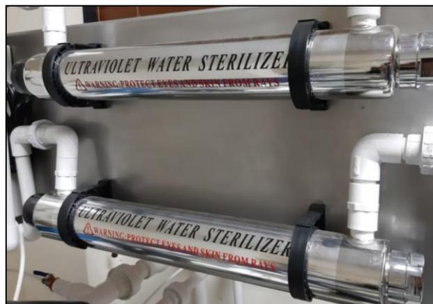
Imagen 7: Sistema ultravioleta esterilizador
