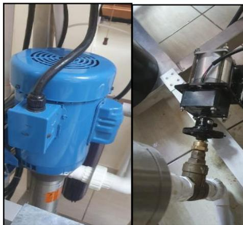
*Figura 4.10* Bomba vertical y motor a pasos
