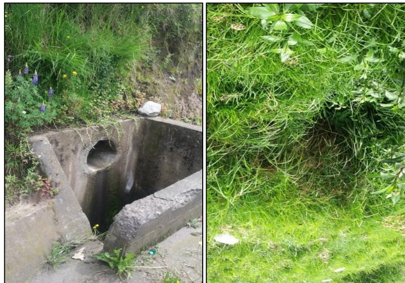
Figura 9: Alcantarilla vial 2 (Elaborado por: Adela Paucar)
