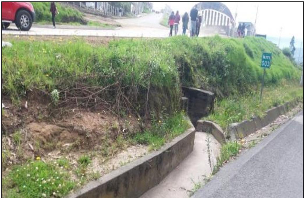
Figura 7: Alcantarilla vial 1 (Elaborado por: Adela Paucar)
