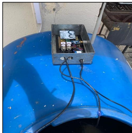
Figura 4-21 Instalación de nodo sensor para la calidad de agua de ingreso. Fuente: Autores
