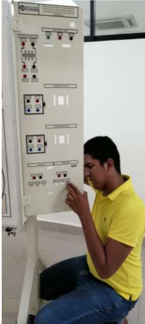
Figura 21. Instalación de Vinil transparente Fuente: Los autores
