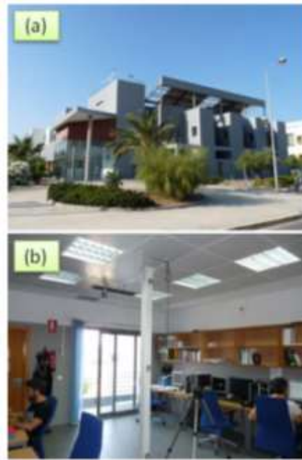
Figura 3. Planta de ensayo: CIESOL. (a) Exterior del edificio, (b) Habitación característica. Fuente: (M. castilla, 2016)
