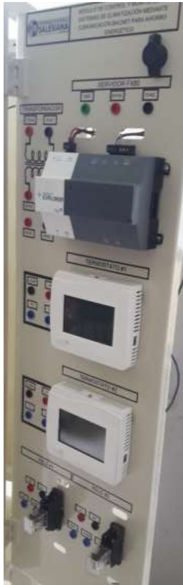
Figura 22. Montaje de Componentes sobre Plafón Fuente: Los autores
