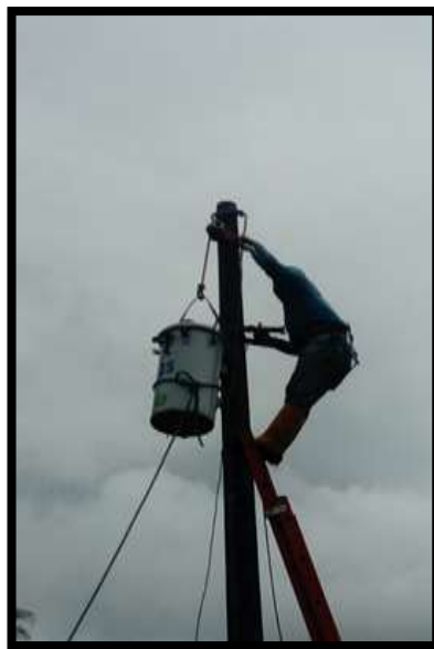
FIGURA 47 ASEFURAMIENTO DEL TRANSFORMADOR.
