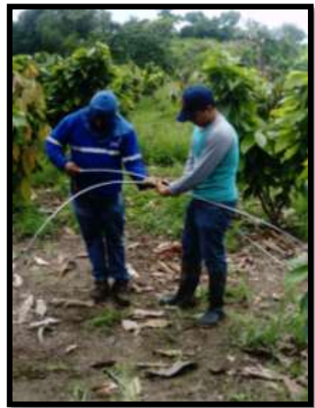
FIGURA 45 ARMADO DEL TENSOR AISLADO DE RETENIDA.
