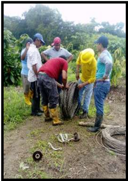
FIGURA 46 PREPARACION DEL CONDUCTOR PARA EL TENDIDO.
