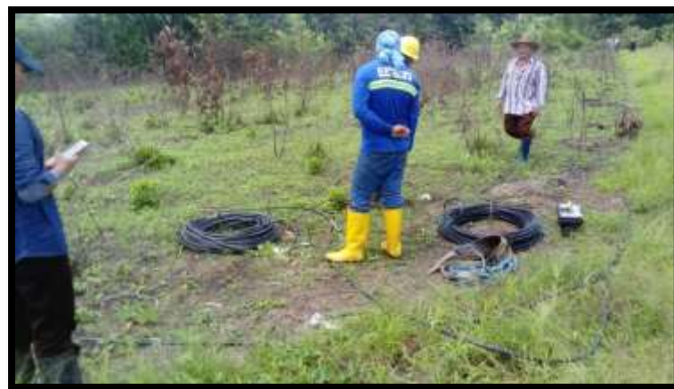
FIGURA 58 PREPARACION DE CONDUCTOR PARA TENDIDO DE ACOMETIDAS.
