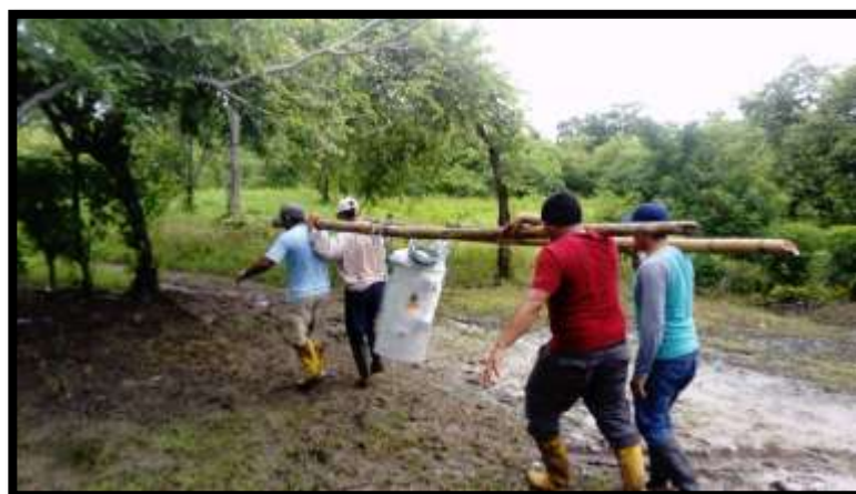
FIGURA 42 TRANSPORTACIÓN DEL TRANSFORMADOR CON EL USO DE CAÑAS.
