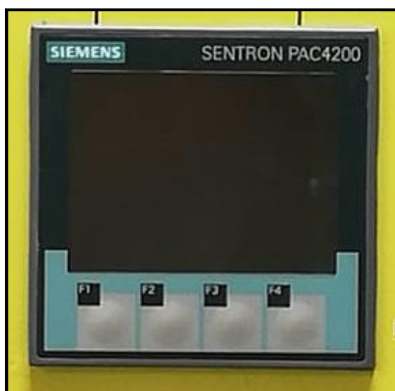
FIGURA 43. ANALIZADOR DE RED. FUENTE: LOS AUTORES
