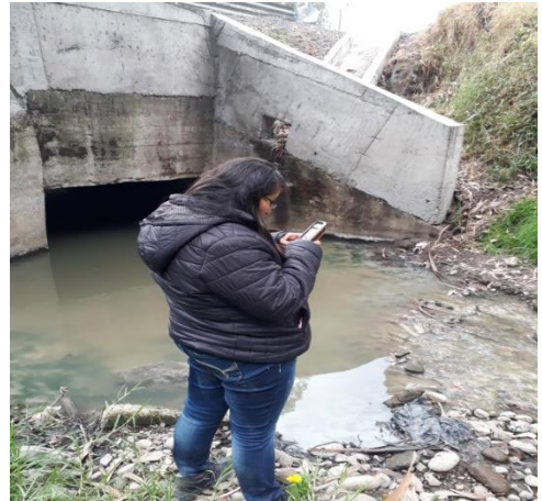
Ilustración 10 Puente del río Puluví
