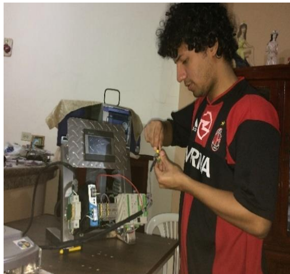
Figura 28: Cableado de PLC Delta.
