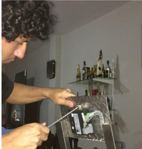
Figura 18: Instalación HMI Delta.
