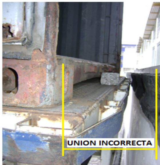
Fotografía 1.3 Unión incorrecta entre contenedor y muelle. Fuente: Bodega de Avon Amaguaña. Elaborado por: El autor.
