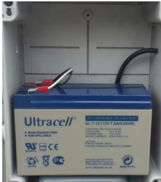
Figura 3.7. Ubicación de la batería en la estación
