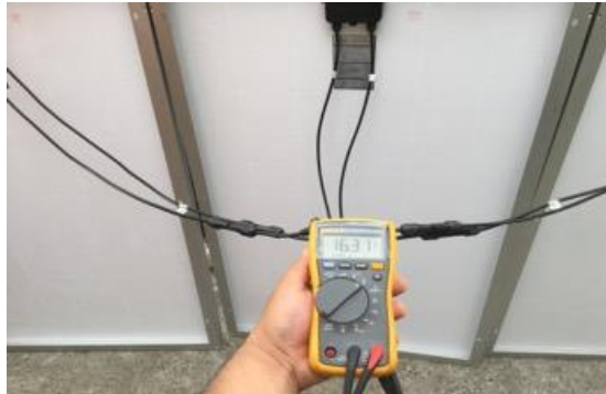
Figura 59. Medición de tensión del módulo solar
