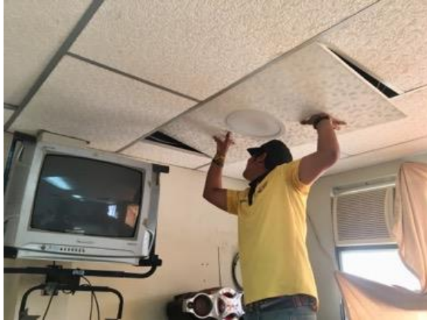
Figura 29. Instalación de lámpara Led de 24W
