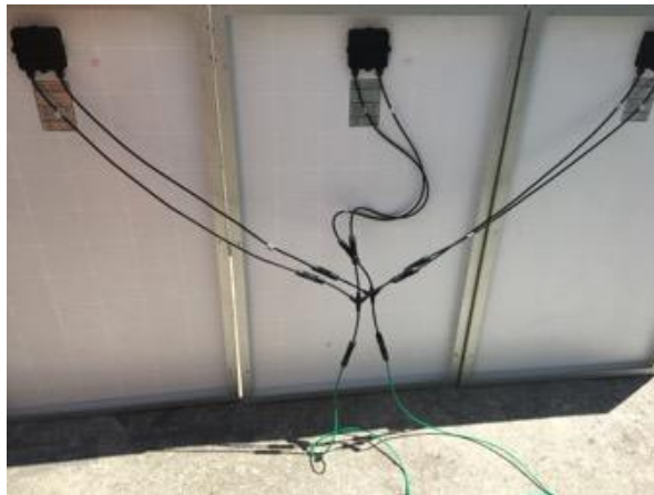
Figura 28. Estructura para módulos fotovoltaicos
