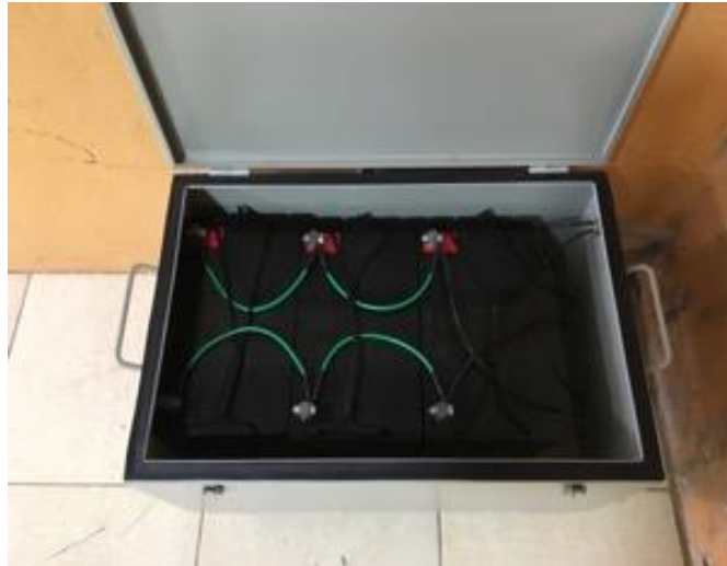
Figura 25. Banco de baterías Universal Battery conectadas en paralelo
