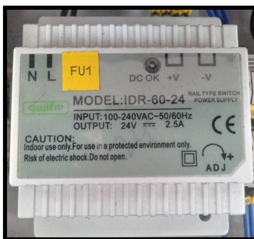
FIGURA 35: FUENTE DE 24 VDC IDR-60-24 VDC
