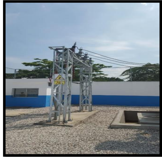
FIGURA 3: ESTRUCTURA PARA EQUIPOS DE 13.8 kV
