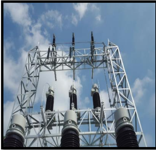
FIGURA 2: ESTRUCTURA PARA EQUIPOS DE 69 kV
