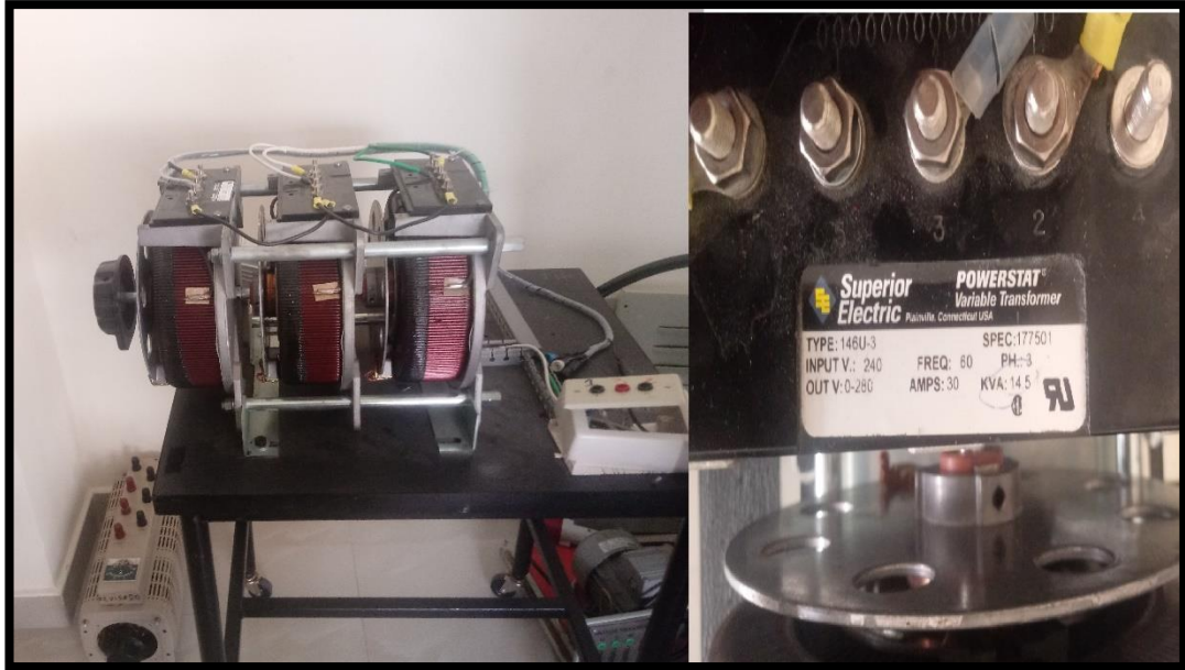
FIGURA 44: TRANSFORMADOR VARIABLE POWERSTAT (VARIAC)
