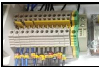
FIGURA 40: BORNERAS WEIDMÜLLER
