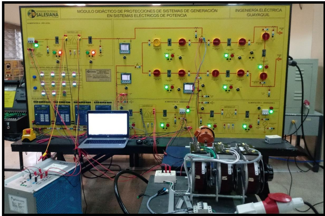
FIGURA 114: MONTAJE PARA OBTENER PARÁMETROS ELÉCTRICOS EN LA COMUNICACIÓN ENTRE PLC CON LA PC
