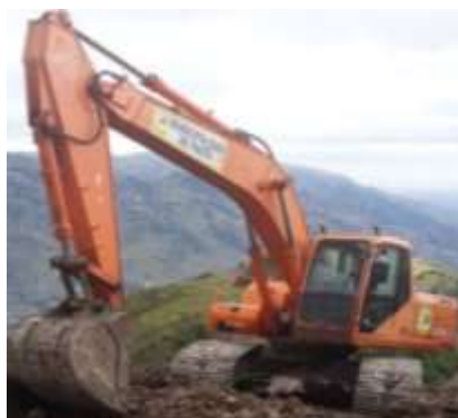
Figura 23. Excavadora de oruga Daewoo Solar220LCV Fuente: Autores
