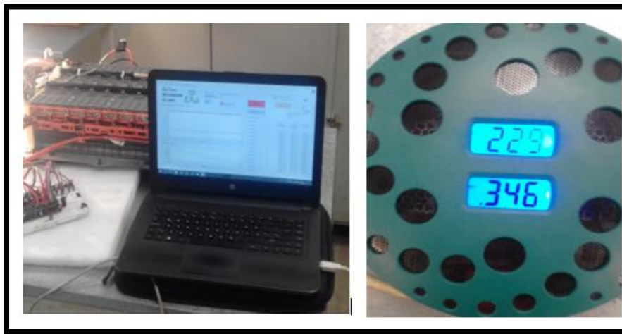
Figura 19. Carga y cargador de batería vehículo híbrido. Fuente: Autores.
