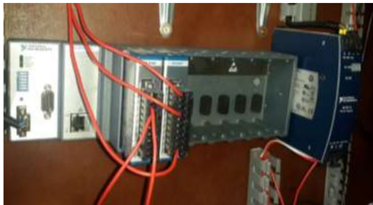
Figura 3.1. Montaje del PAC
