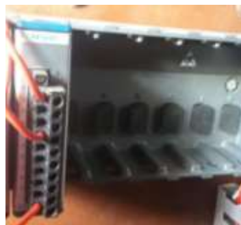
Figura 3.10. Conexión del circuito convertidor a la entrada AI0
