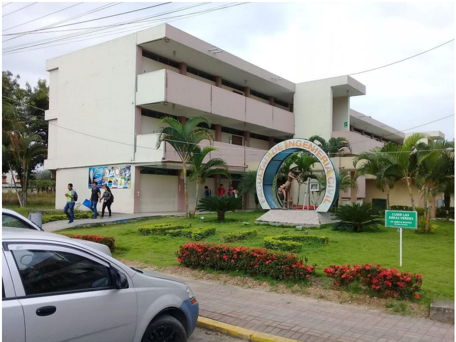
Figura 11. Bloque de Aulas de la Facultad de Ingeniería Civil de la Universidad Técnica de Machala.
