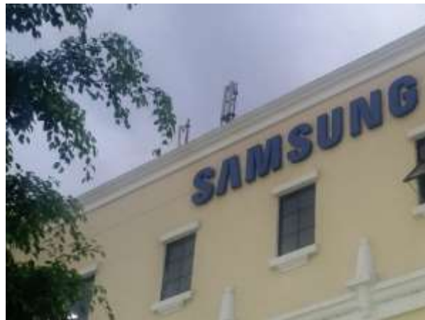
Figura 4.16. Estación Base San Marino.
