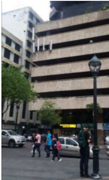
Figura 4.13. Estación Base San Francisco 300.
