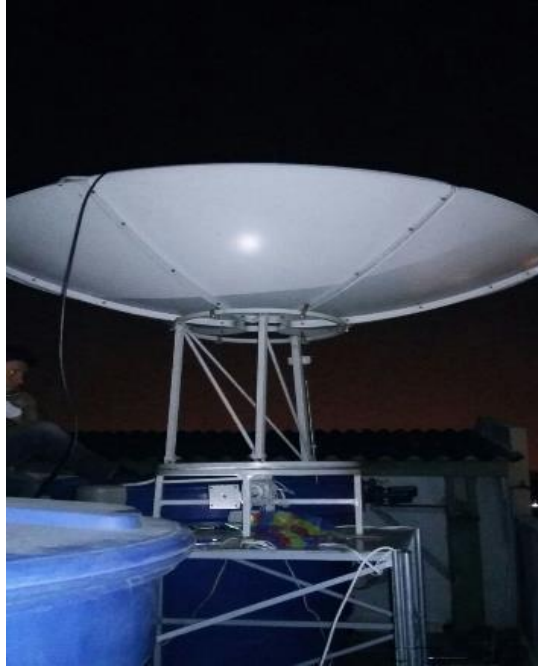
Figura 75: Colocación de la antena satelital en la terraza del Bloque B de la Universidad Politécnica Salesiana.
