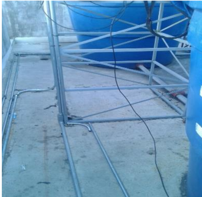
Figura 77: Instalación de tubería para conexión de antena sensores motores de paso.
