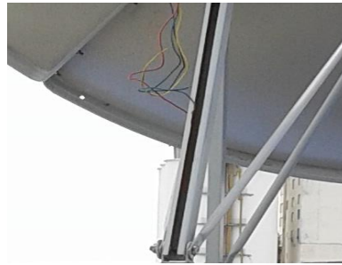
Figura 37: Corte en el tubo del soporte de la antena.
