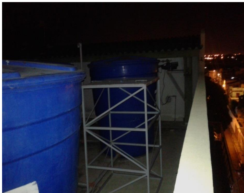
Figura 40: Torre para antena satelital
