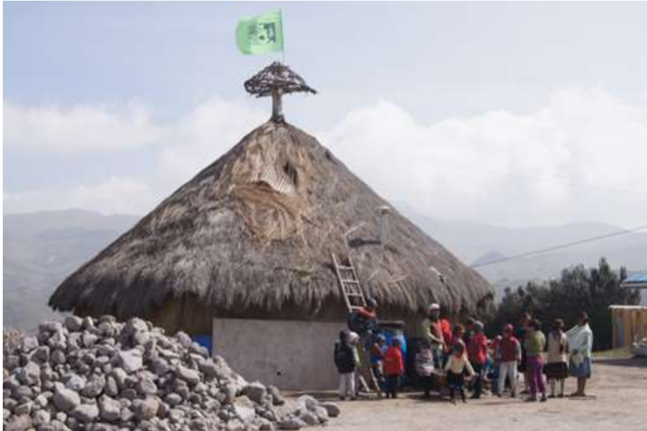
Figura 3. Plazoleta de Tingo Pucará con la casa principal para alojamientos Fuente: Investigador
