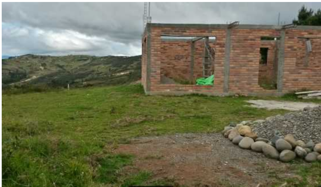
Fotografía 4. Infraestructura en construcción en las inmediaciones del Bosque Protector Aguarongo. Fuente: Grupo de Investigación en Biotecnología y Ambiente (INBIAM). 2016
