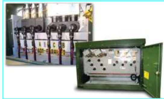
FIGURA 2.7 INTERRUPTOR TRIFÁSICO TIPO PEDESTAL [6]
