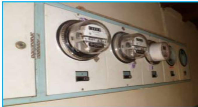
FIGURA 2.20 TABLERO DE MEDIDORES FUENTE: LOS AUTORES
