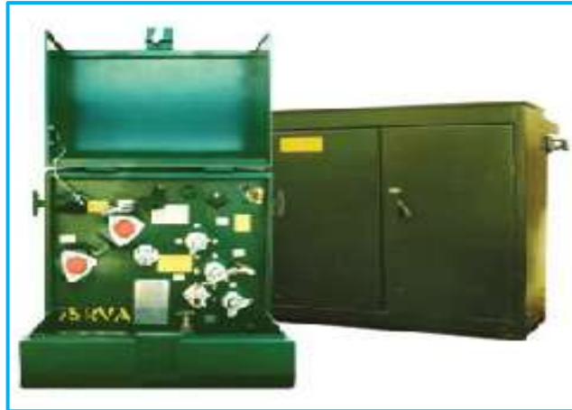
FIGURA 2.5 TRANSFORMADORES TIPO PEDESTAL [8]
