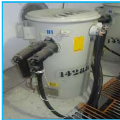
FIGURA 2.6 TRANSFORMADOR CONVENCIONAL CON FRETE MUERTO [6]
