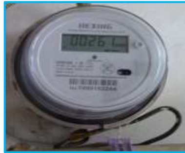
FIGURA 2.19 MEDIDOR DE ENERGÍA ELÉCTRICA FUENTE: LOS AUTORES
