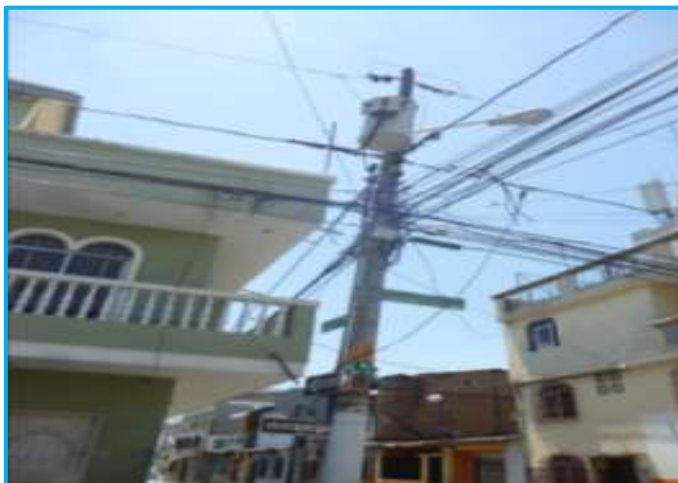
FIGURA 3.6 MEDIDORES CONTROLADORES DE CIRCUITOS ACTUALES FUENTE: LOS AUTORES
